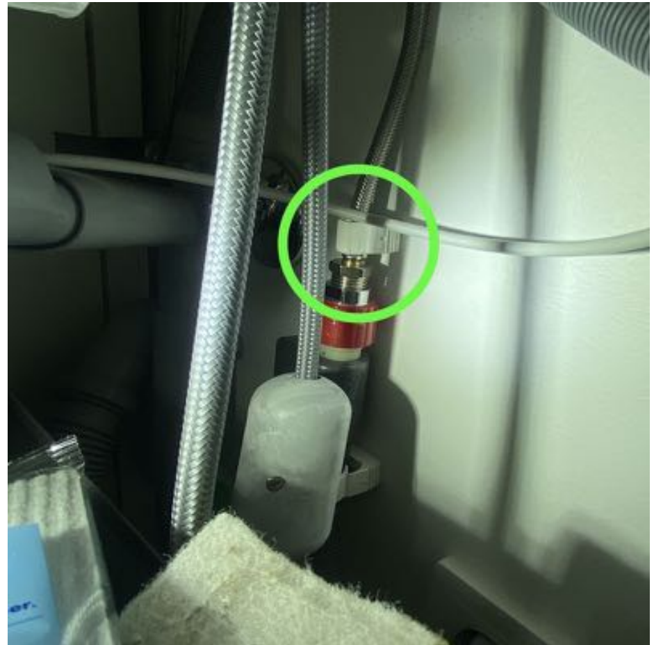
16. Yleiskuva: Astianpesukoneen vesijohdon kannakointi on ohjeiden mukainen (kiinnitetty seinään).
