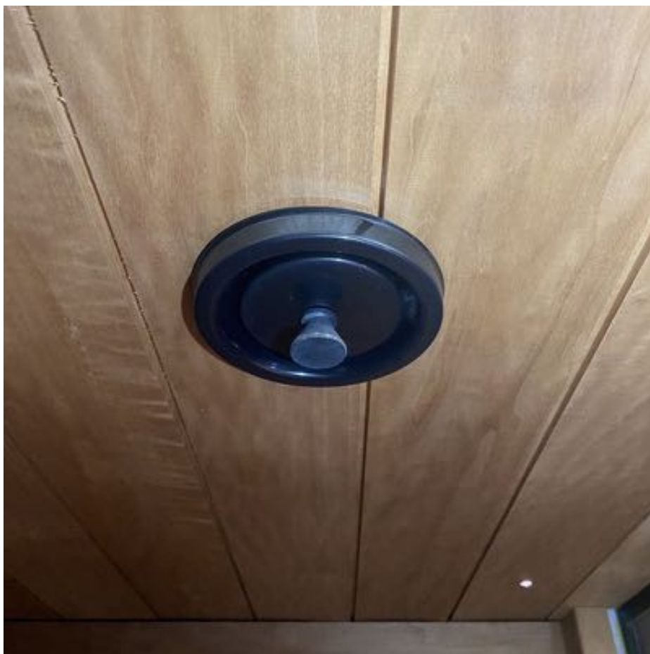
5. Yleiskuva: Saunassa on nupillinen poistoilmaventtiili. Nupillisella poistoilmaventtiilillä pystytään tehostamaan saunan kuivatusta käytön jälkeen. Muulloin venttiili voi olla sulkuasennossa (painettu kiinni).
