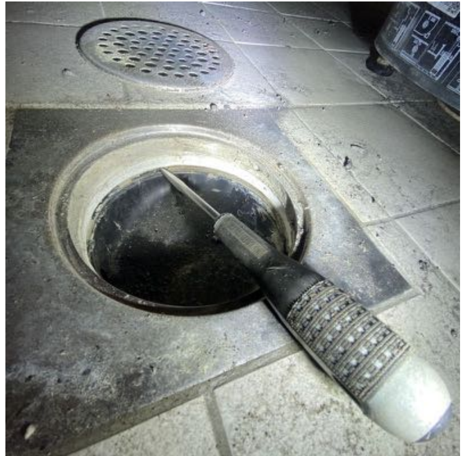
4. Yleiskuva: Saunan lattian vedenpoisto on järjestetty kuivakaivolla. Kuivakaivon liitos lattian vedeneristeeseen on näkyviltä osin nykyohjeiden mukainen (havaittu vahvikekangas kiristysrenkaan alla).
