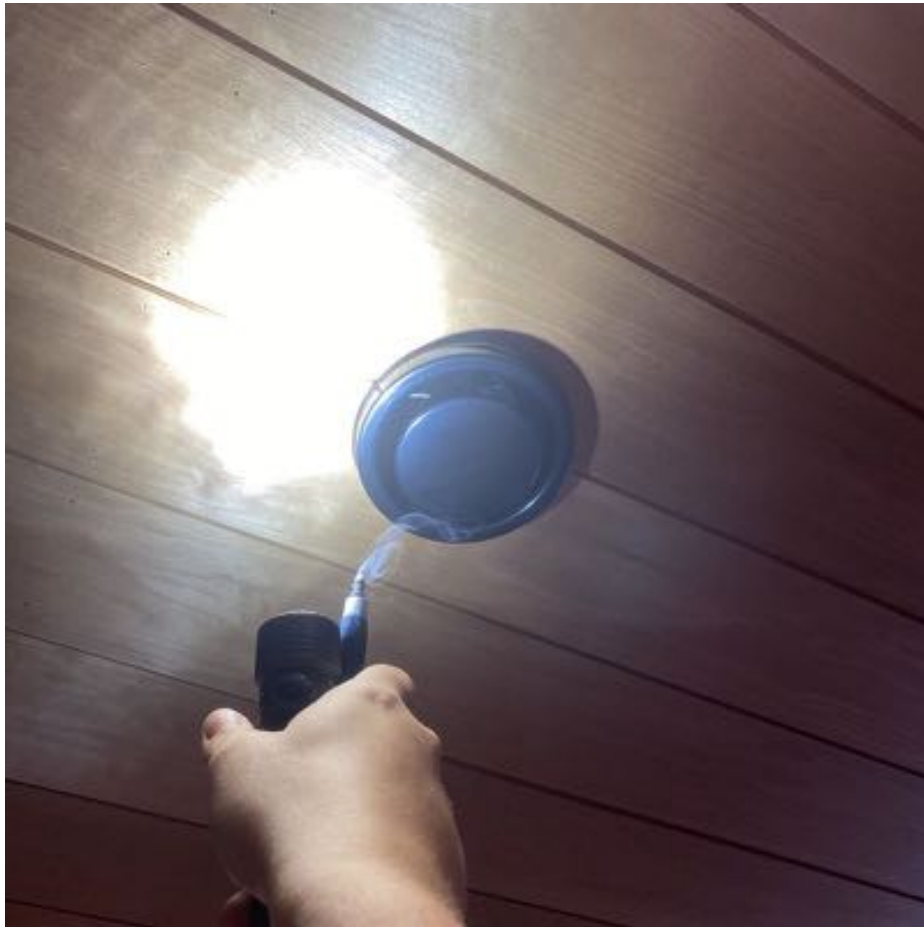
11. Yleiskuva: Pesuhuoneen ja saunan poistoilmanvaihdon toimintaa testattiin merkkisavulla. Ilmavirtaussuunnissa ei havaittu puutteita.
